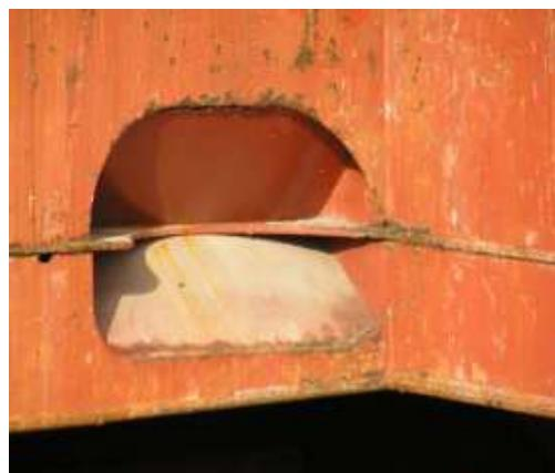
Рис. 9. Разрушение конструкции угла люкового выреза на т/х «Виктория». (Фото 2010 г.)
