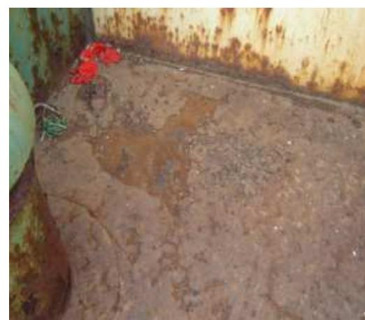
Рис. 2. Коррозия палубы в районе надстройки супертраулера «Президент Пик»
