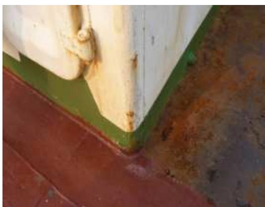
*Рис. 10. Трещина (закрыта накладной полосой) в верхней палубе в районе пересечения стенок рубки и переборки под палубой («жесткая точка») на т/х «Остров Карагинский» (Фото 2009 г.)*
