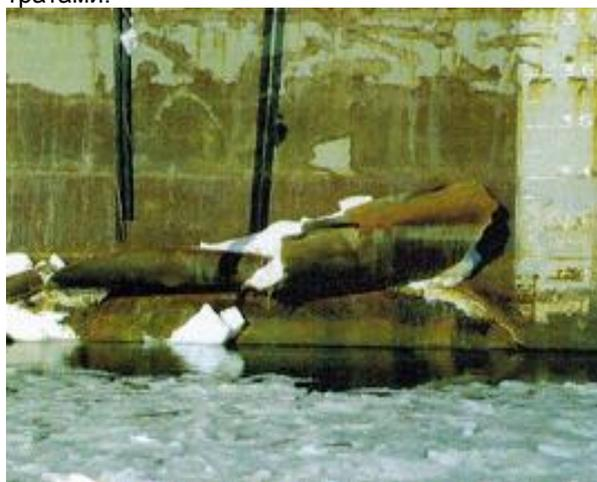
Рис. 2. Тяжёлые разрушения в районе ледового пояса морской буровой платформы
