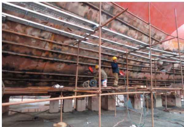
Рис. 4. Реализация ледовых усилений в Китае
