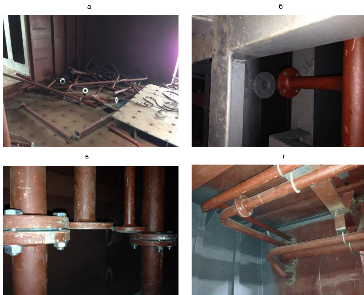
Рис. 3. Монтаж трассы трубопроводов из готовых труб, изготавливаемых по проектной информации а – трубы, изготавливаемые по проектной информации, которые отправляются для монтажа на судне; б – фактические отклонения конца трассы в трёх координатных направлениях; в, г – положения совмещения соединений трассы после компенсации отклонений.
