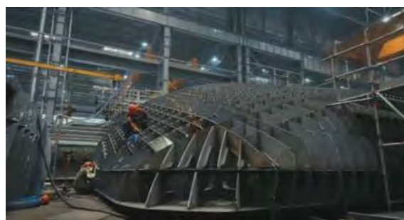
Рис. 12. Изготовление набора и сборка носовой секции многоцелевого судна снабжения усиленного ледового класса, строящегося по проекту IBSV 10022 АН
