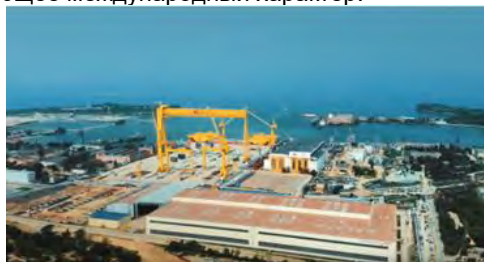
Рис. 1. Судостроительная верфь ССК «Звезда». Здания блока цехов (а) и
