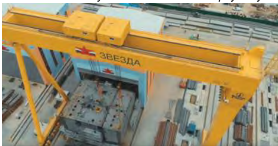
Рис. 15. Использование крана «Голиаф» для сборки крупных корпусных модулей судна усиленного
