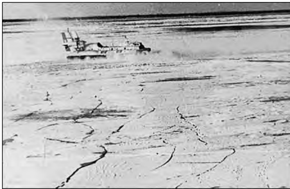
Рис. 3. Возникновение во льду длинных поперечных трещин от ИГВ, возбуждаемых СВП "Скат"
