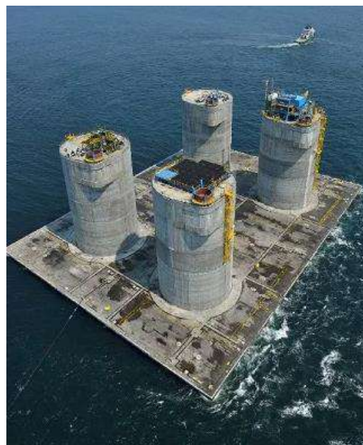
Рис. 3. Транспортировка нефтяной платформы Беркут, июнь 2012 г. (высота 41 метр и вес 130 000 тонн) [4]
