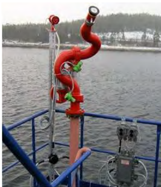
Рис. 1. Стационарный лафетный ствол СЛС в вышке [3]
