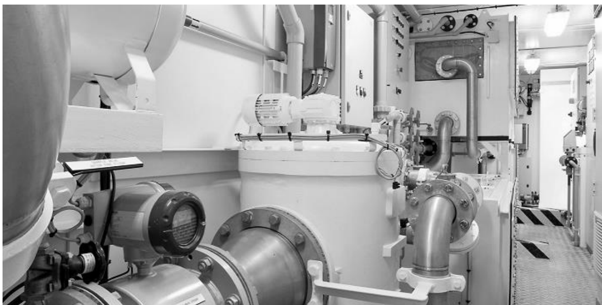
Рис. 1. Система очистки судовых балластных вод в мобильной конфигурации InvaSave [5]
