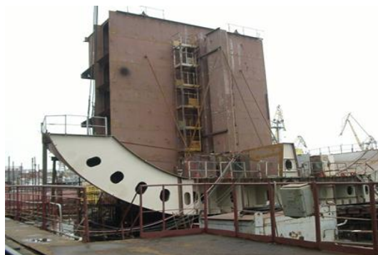
Рис. 3 Пример размерного контроля при установке поперечной переборки на стапеле
