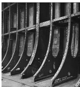
Рис. 8 Фрагмент металлической клепанной конструкции корпуса судна (1907г.)
