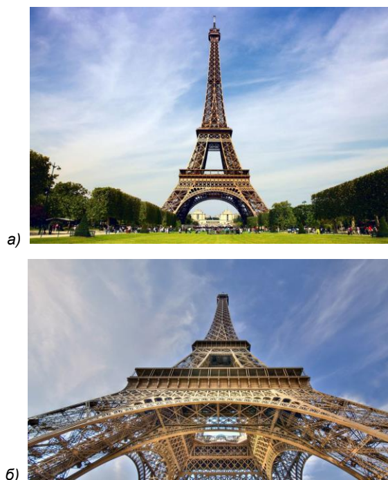
Рис.2. Эйфелева башня состоит из 18038 металлических деталей и 2,5 млн. заклепок, масса металлической конструкции — около 7300 тонн: а) общий вид; б) вид снизу на детали нижнего яруса.
