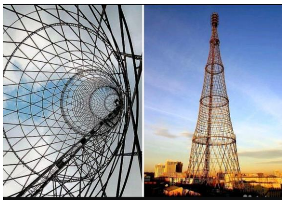
Рис.3. Шуховская радио (позднее телевизионная) башня в Москве на Шаболовке, высота 148,5 метра, масса 240 тонн.
