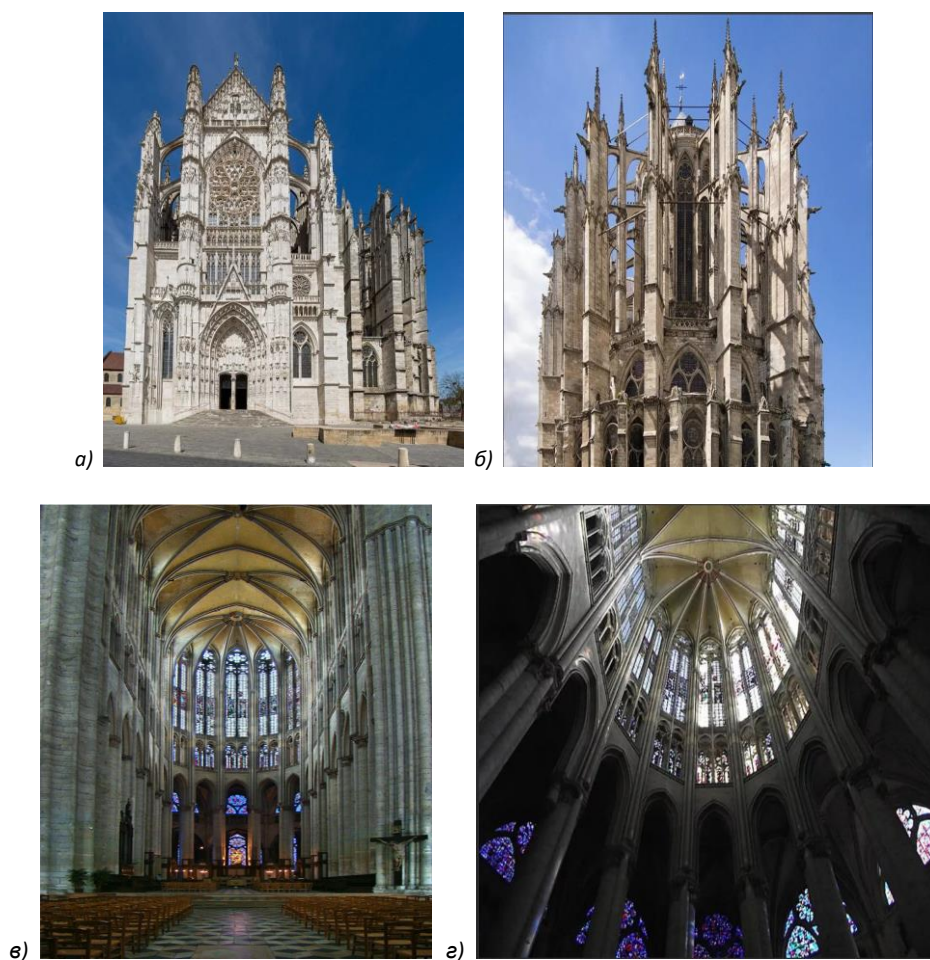
Рис.1. Собор Святого Петра в Бове с самыми высокими готическими хорами в мире (48,5м): а) вид спереди; б) вид сзади (видны актбутаны, передающие наагрузки от свода со стен на контрфорсы, растяжки и распорки); в) интерьер собора; г) свод.
