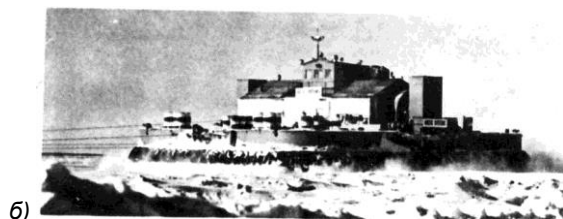
Рис.1. а) Разрушение льда толщиной 0.69 м паромом АСТ-100; б) Общий вид парома в ледовых условиях
